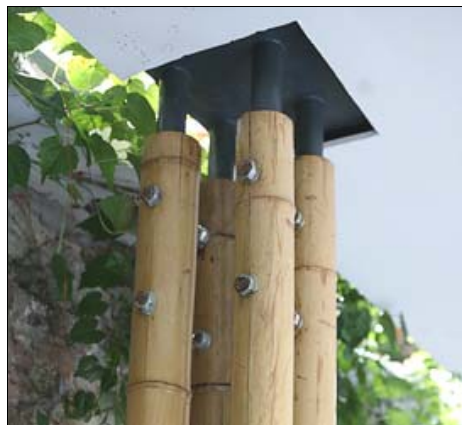
Bamboe is op zijn best wanneer het in de lengterichting belast wordt. Vier bamboestengels vervangen hier een stalen steunbeer
