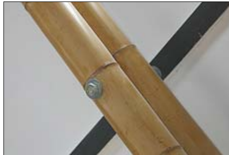
Om het doorbuigen van deze dakspant te vermijden werd gewerkt met een gordingslat en een vijzelsysteem
