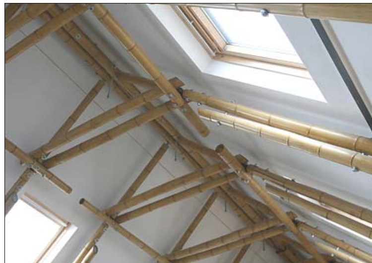
Bij het maken van een dakconstructie is het ecologisch en sociaal verantwoorde bamboe een ideaal, goedkoop en gebruiksvriendelijk alternatief voor hout
