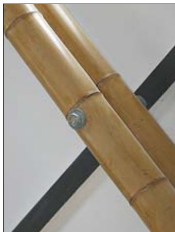
Doorbuiging werd hier opgevangen door een gordinglat en een vizelsysteem
