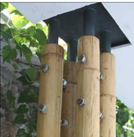
Bamboe is op zijn best wanneer het in de lengterichting belast wordt
